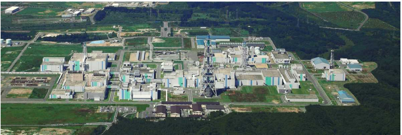
六ヶ所再処理工場（日本原燃）
