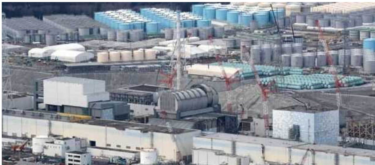
廃炉作業中の福島第一原発(2018年4月/朝日新聞)
